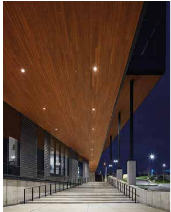
CLADDING سقف و نمای چوبی
